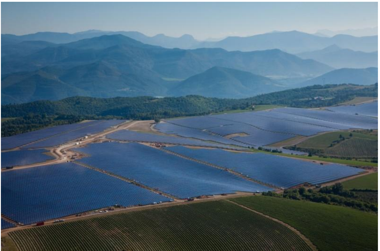
Centrale solaire Les Mées, PACA, @Divergence-image
